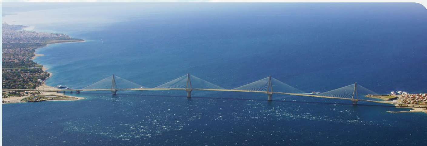
Dálniční most Rio – Antirio, Peloponésos je vlevo. Stavba byla ohromně komplikovaná kvůli nepevnému dnu, seismickému prostředí, hloubce vody 60 m a postupně se vzdalujícími břehy zálivu (30 mm/rok).
