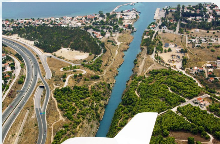
Dálniční přivaděč dálnice Athény – Peloponésos ústící na most přes Korintský kanál.
