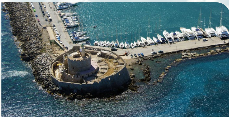
Detailní pohled na místo, kde měla stát socha Kolosa.
