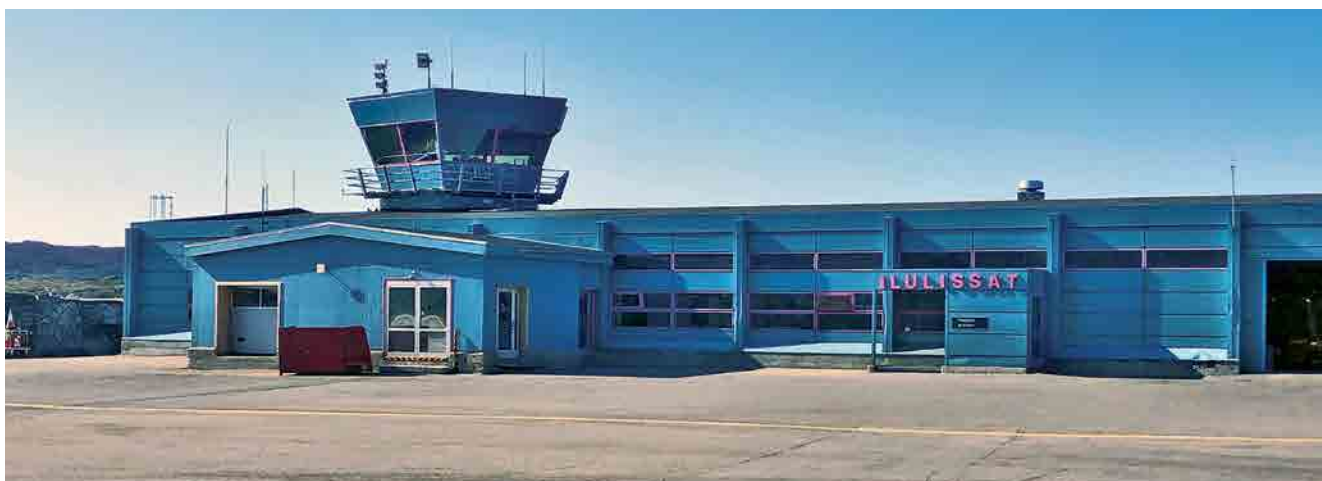
■ Budova terminálu s letištní věží letiště Ilulissat
